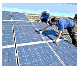
La posa di pannelli fotovoltaici sul tetto di un'abitazione privata (foto di repertorio)
