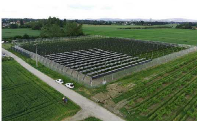
Vista aerea del frutteto S40 nelle sue parti: controllo monoblocco (in basso a destra) e copertura ombreggiante (in basso a sinistra)
